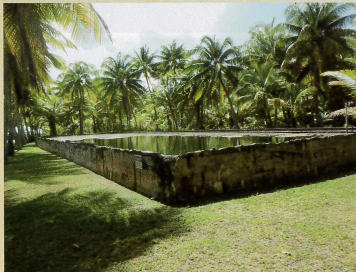
ルオットには日本軍が築いた貯水槽が残っている。プールのような大きさで今も雨水をたたえている。
