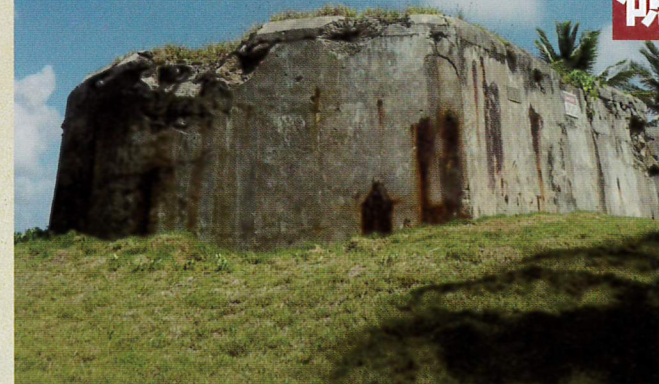
(上) ルオットに残る日本軍のトーチカ。珊瑚礁の島は地下を掘れないため、構築物は地上に露出し空襲の目標にされた。補給が途絶え、セメントも資材も不足した。(右) クエゼリン本島の日本軍トーチカ跡。島内は全域がゴルフ場のように芝生に覆われている。米軍は日本軍の一部の遺構を白い柵で囲み、戦闘場面の写真や解説プレートをつけて維持管理している。
