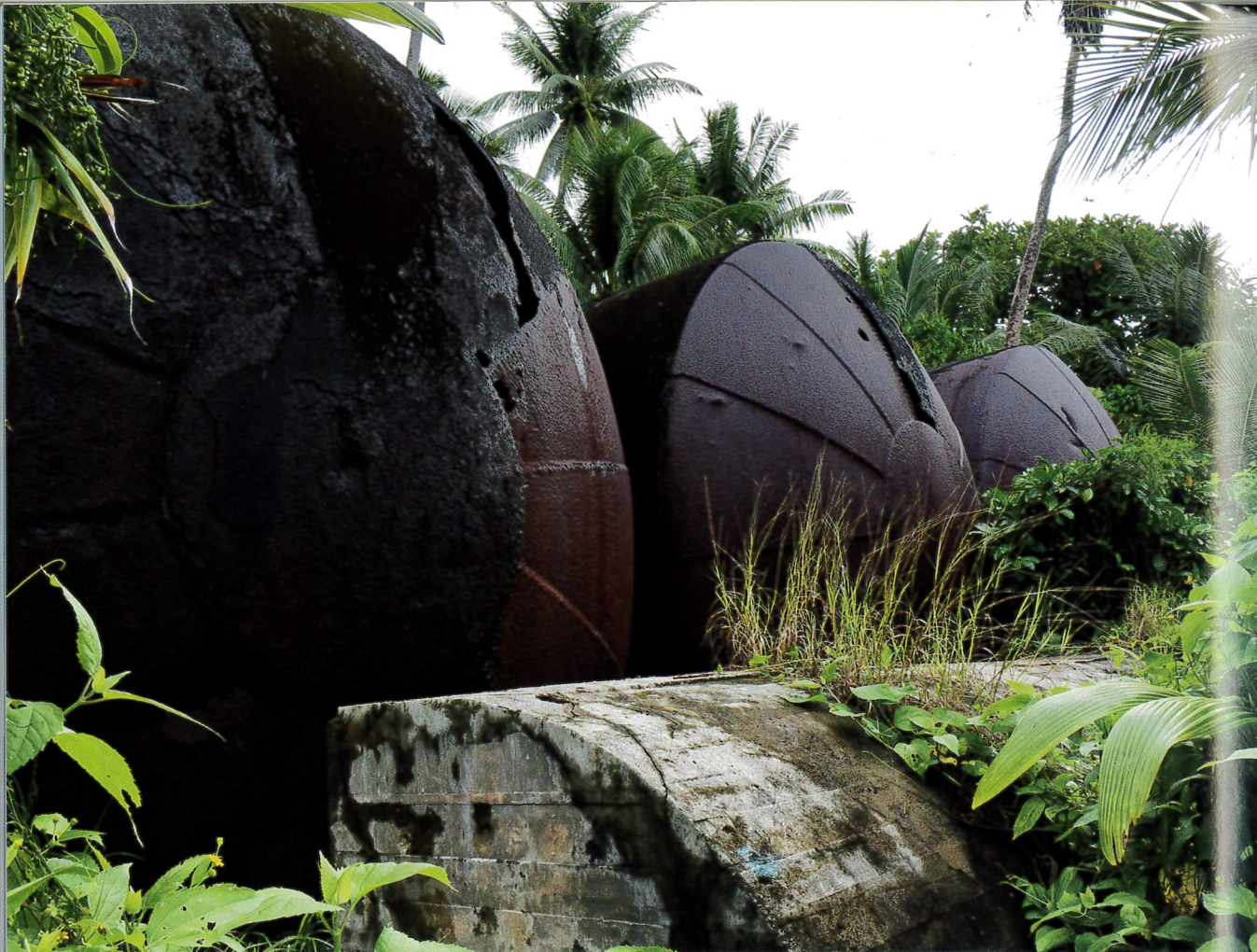
巨大な貯油（燃料）タンクが3つ並ぶ。直径は4~5m程もある。環礁の土地は深く掘ることができないため、建物や構造物のほとんどが地上にむきだしになっている。当時、ここに屋根や囲いがあったかは不明だ。
