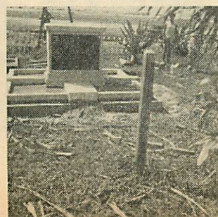
据付を了る(裏)
