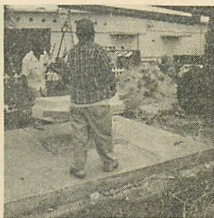
基礎石据えつけ
